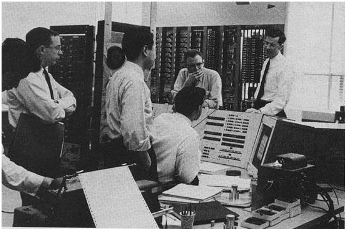
Fig. Computer TX-0 basato su tecnologia a transistor.
