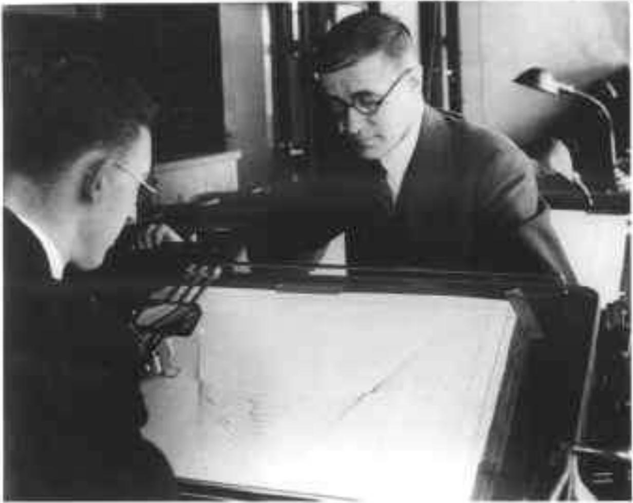
**Operatore (Samuel Caldwell) alla console dell'analizzatore differenziale, costituita da un'interfaccia di tipo grafico. L'operatore manipolava a mano un puntatore per seguire le curve sulla carta, che venivano poi integrate (o elaborate in altro modo) dalla macchina fino a diventare un grafico in uscita. Vannevar Bush osserva la console.**
